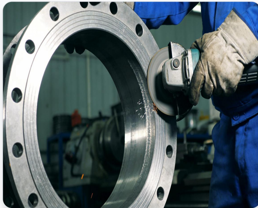
图示：维修人员正在研磨密封面
