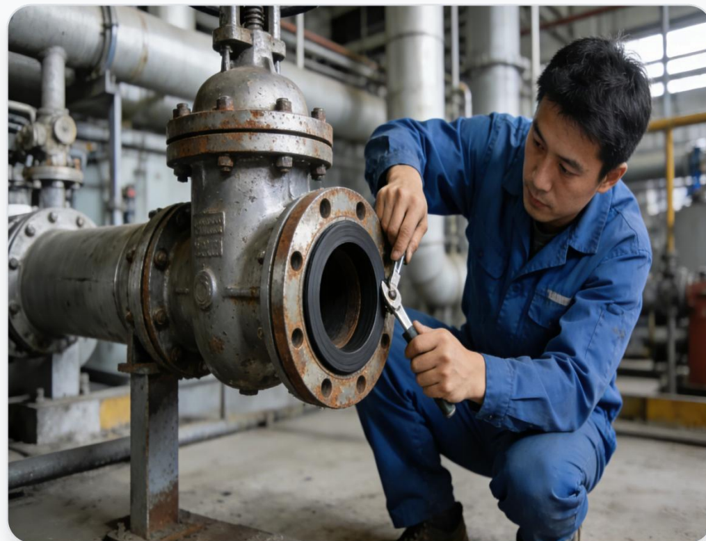
图示：工人正在更换阀门法兰垫片
