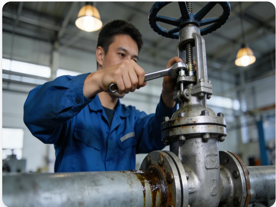
图示：技术人员正在拆卸阀门执行机构进行检修
